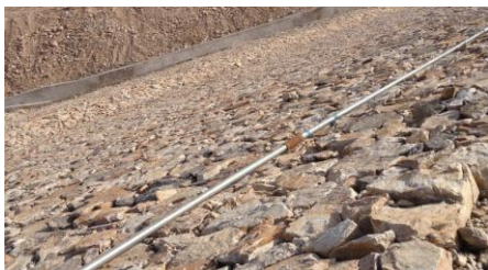
市电安装实例图
