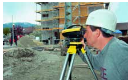
建筑沉降观测
