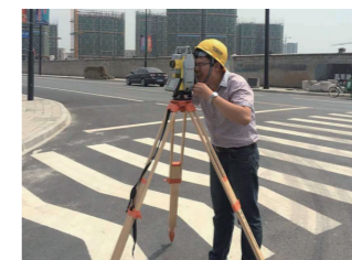
杭州市政管线测量
